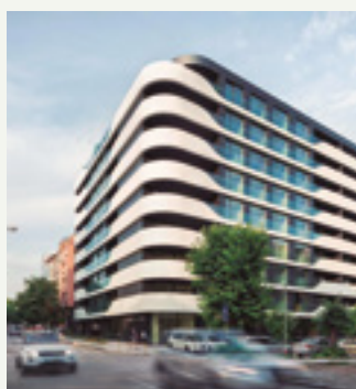
Výjimečná obytná budova v Bulharsku s efektivním řešením klimatizace. Aquarea
