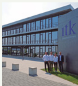
ITK Engineering GmbH. Inovativní kancelářská budova nacházející se v Německu. ECOi - PACi
